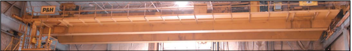
P&H 30 ton bridge crane
